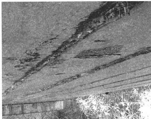
写真2 桁下面の状況
