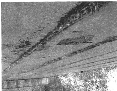
写真2 桁下面の状況
