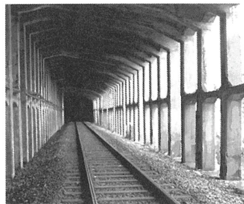
写真1 スノーシェッドの現況
