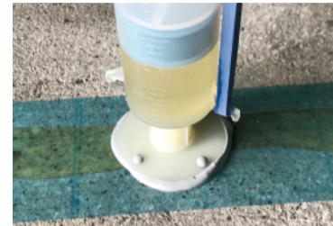
本工法 シールテープ目止め+自動式低圧注入
