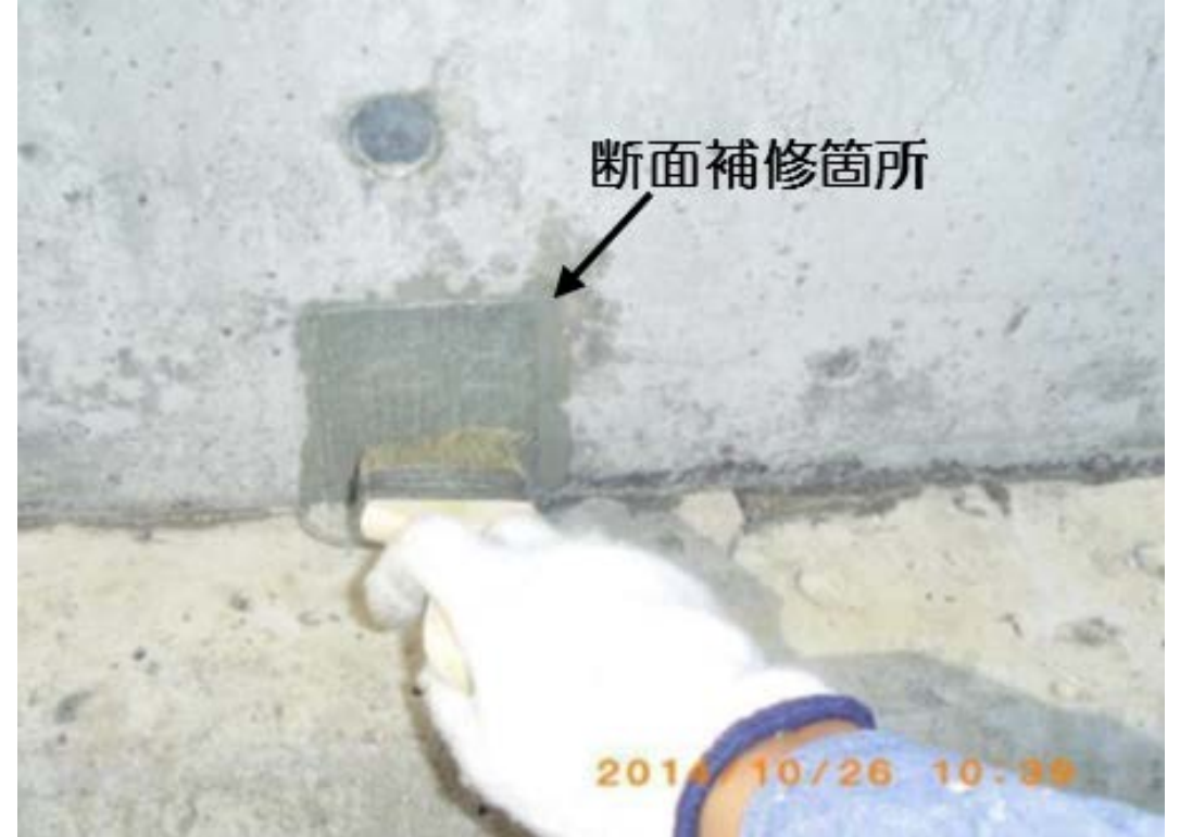
写真-9 断面修復後に防水材塗布
