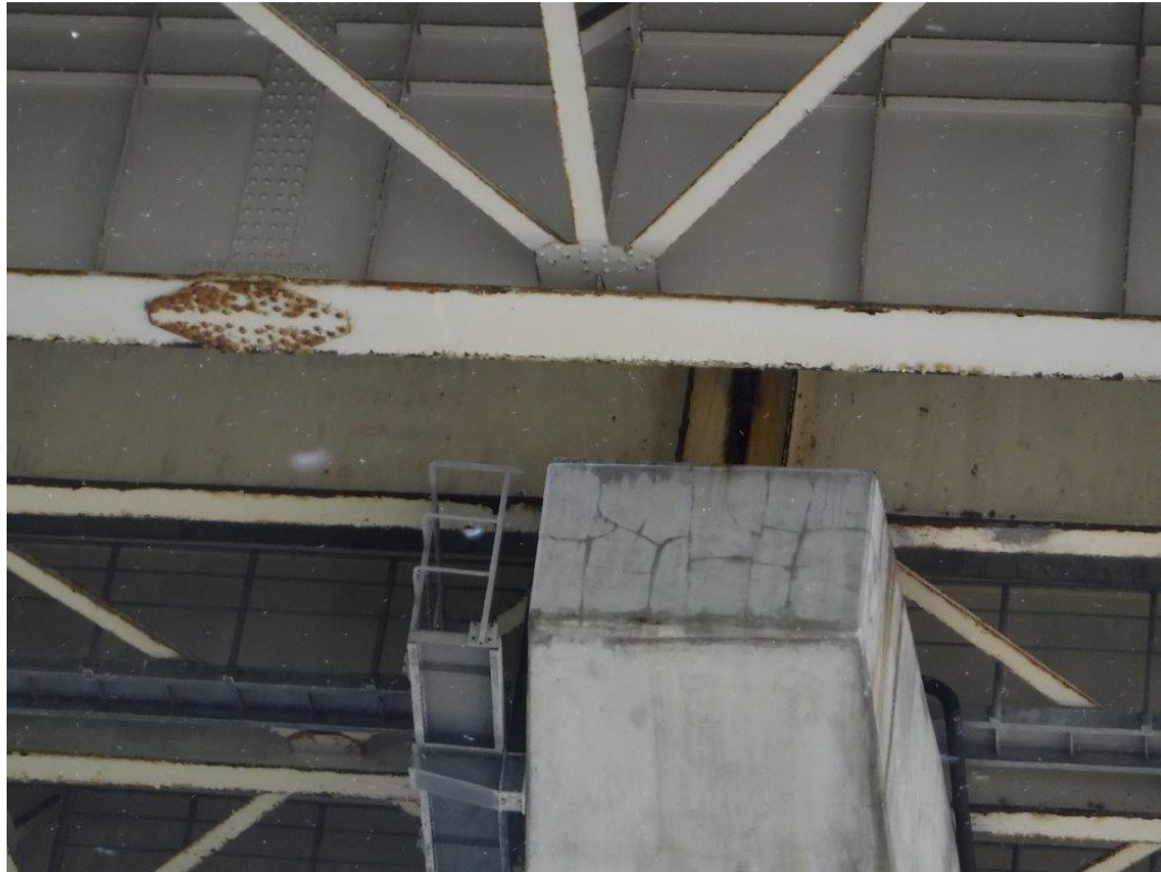
写真-3 上面からの水掛りによるひび割れ
