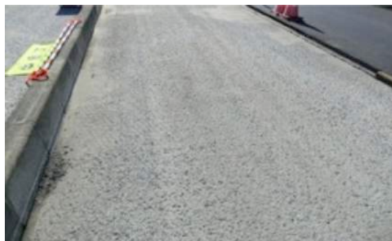
写真-1 コンクリート床版上層部の切削痕
