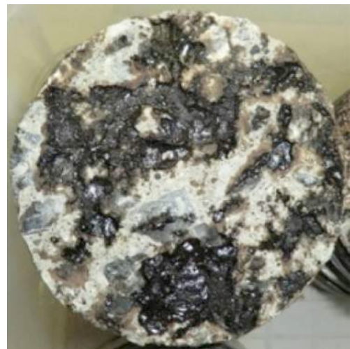
写真-3 引張接着試験結果（コンクリート床版破壊）
