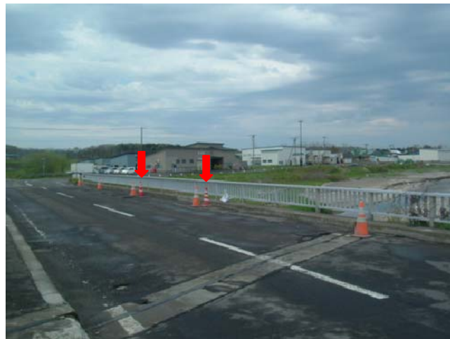
写真 3-1 橋軸直角方向の設置位置
