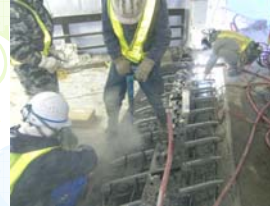
打設面清掃、吸水
