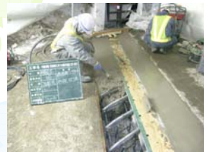
ジェットコンクリート打設
