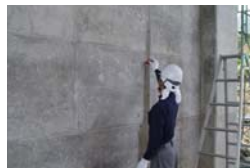
(削孔部の清掃—ゴムチューブ)
