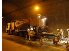
ジェットコンクリート打設(モービル車)
