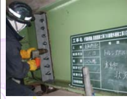
補剛材設置(高カボルト)
