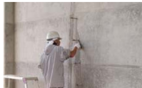
(削孔部の清掃—ゴムチューブ)
