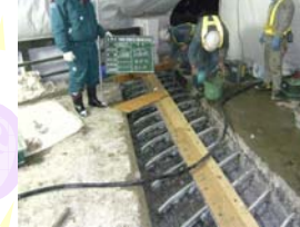
打設面清掃、吸水
