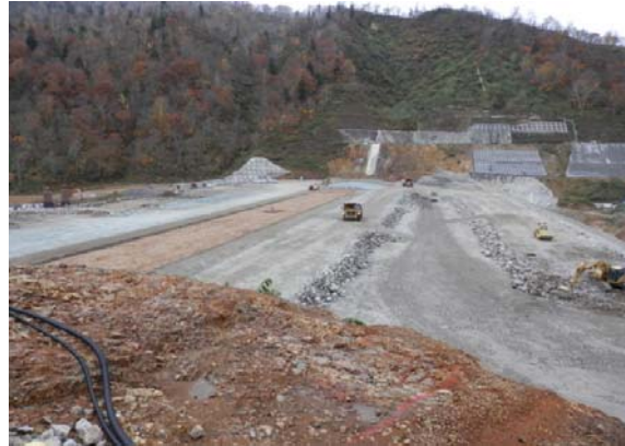
写真7 下部ダム堤体盛立状況(京極水力発電所)
