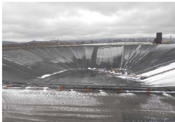
写真3 上部調整池(京極水力発電所)
