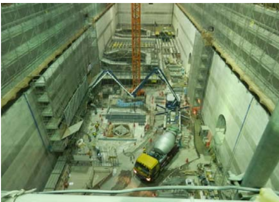
写真5 地下発電所の内部(京極水力発電所)
