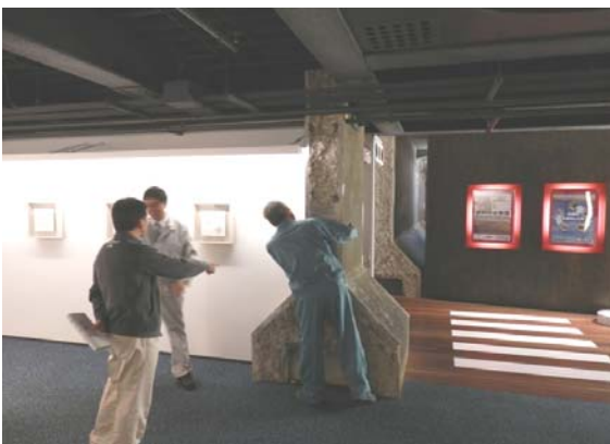
写真1 昭和12年建設当時のコンクリートの表面を観察する参加者(札幌市水道記念館)
